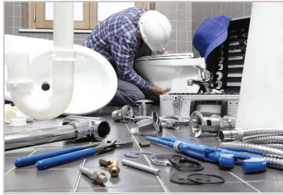
Görsel 3.44: Sıhhi tesisatta çalışma
